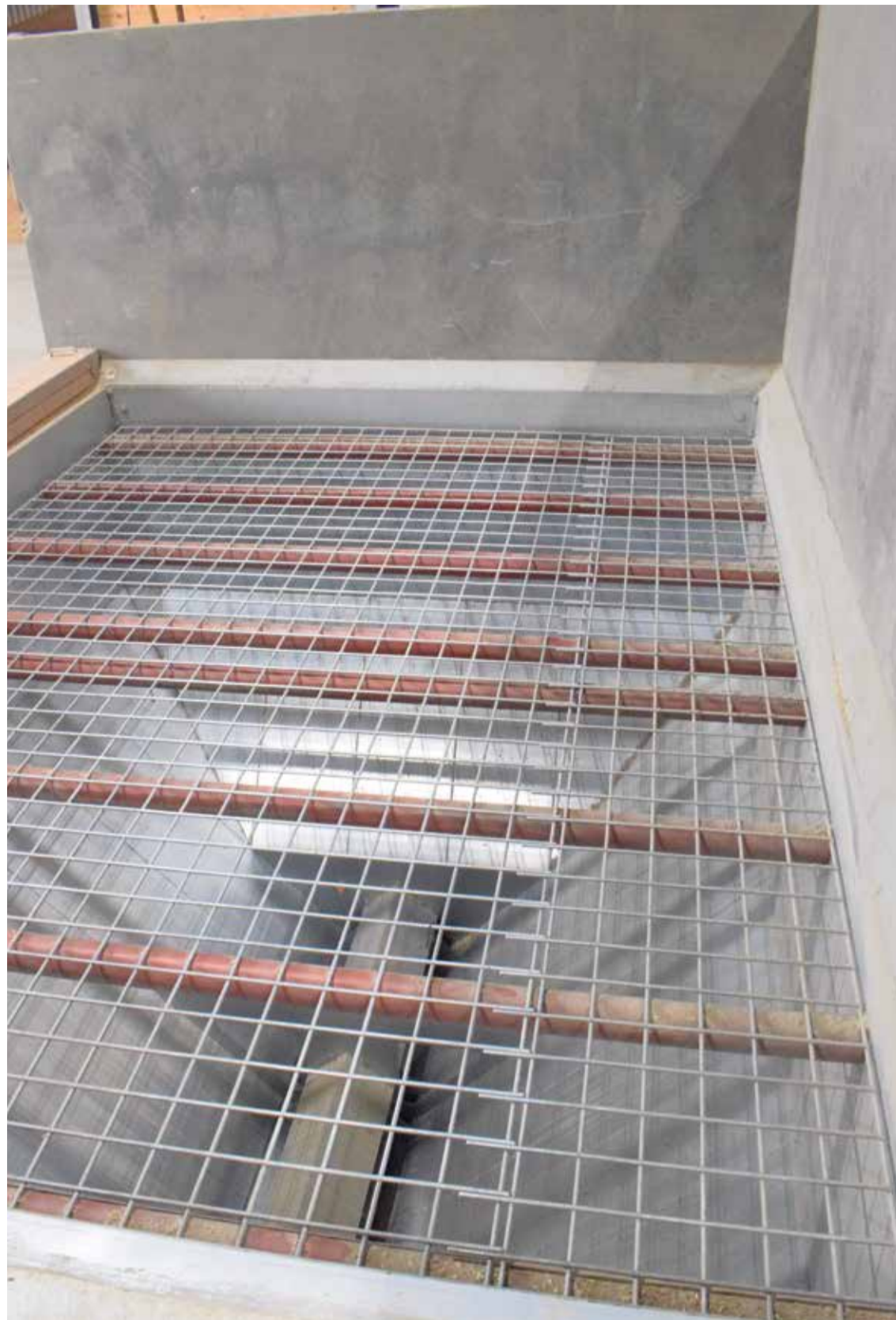
De drypit in de nieuwe schuur van Mellema.
