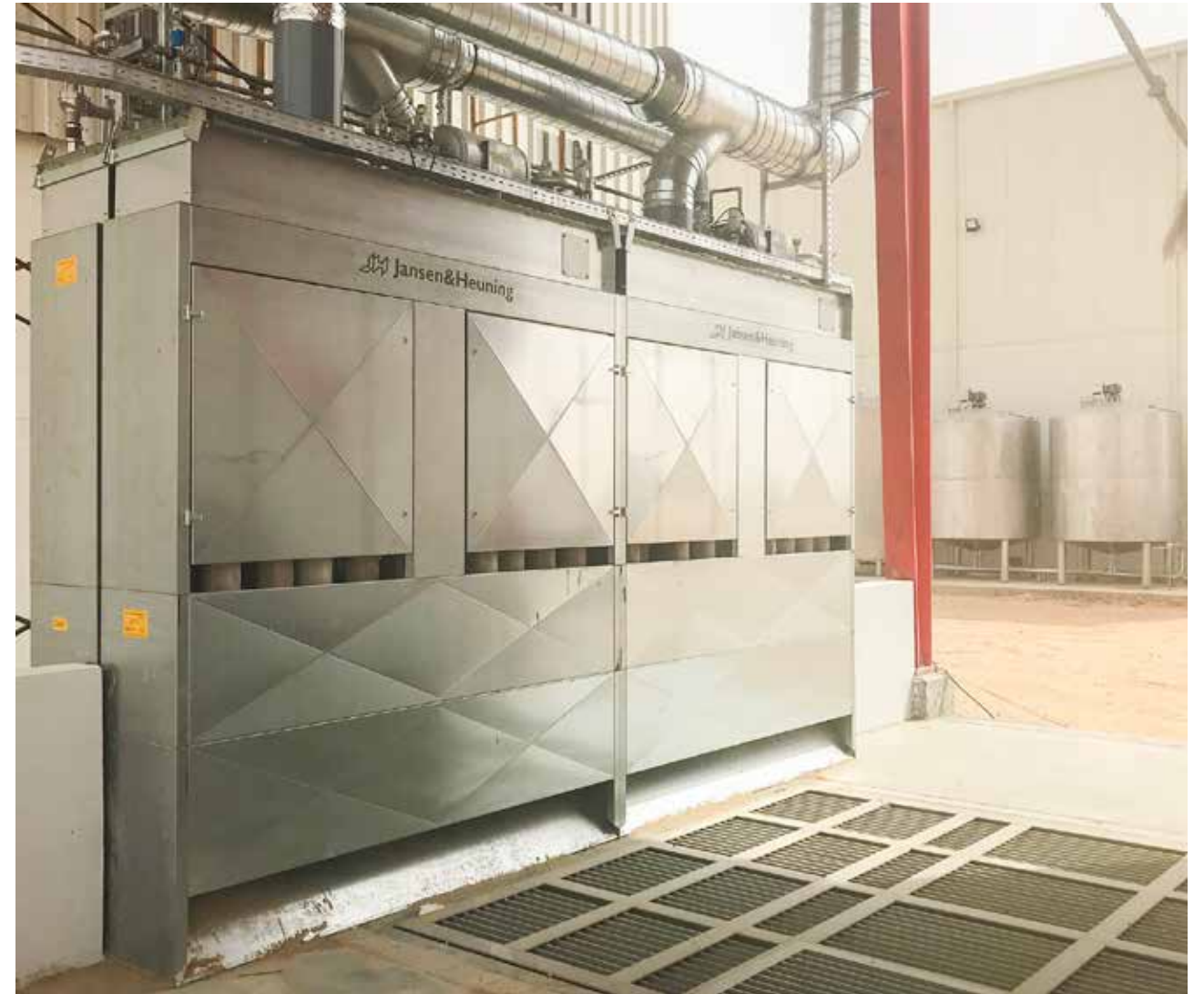
↑ Aanvoer van granen in de stortputten met stortputfilters.
